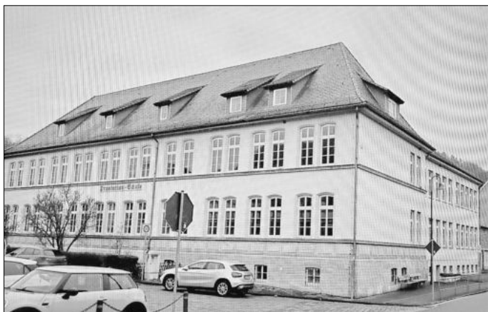
Die Umbauarbeiten an der Creuzburger Praetoriuschule stehen kurz vor dem Beginn. Nach dem Eingang eines weiteren Fördermittelbescheids vergibt der Stadtrat im März die ersten vier Baulose.
