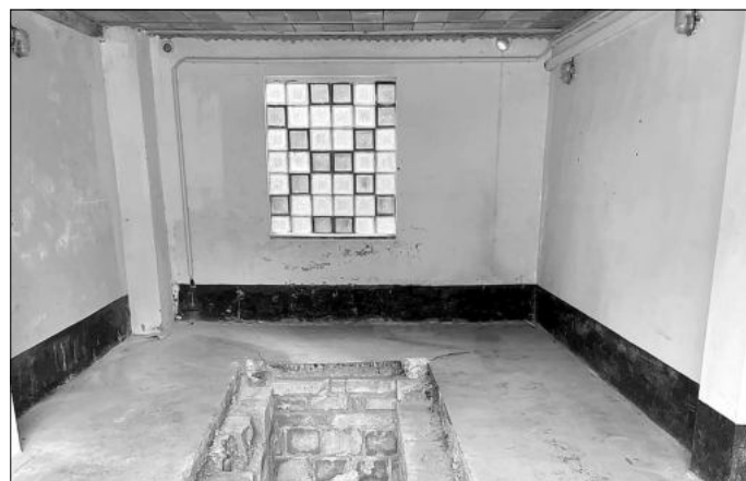
Vor der Erneuerung des Fußbodens wurde die nicht mehr benötigte Arbeitsgrube verfüllt. Die Glasbausteine wurden durch ein Fenster ersetzt.
