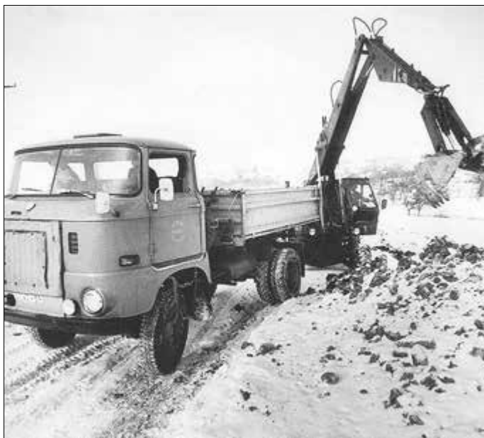
Schwere Technik des VEB „Aufbau“ Mihla beim Verlegen von Abwasserrohren im Bocksgaben, Januar 1987
