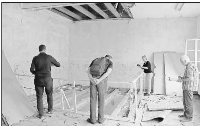
Besichtigung der Deckendurchbrüche für den zukünftigen Fahrstuhl. Amt Creuzburg Foto: Lämmerhirt
