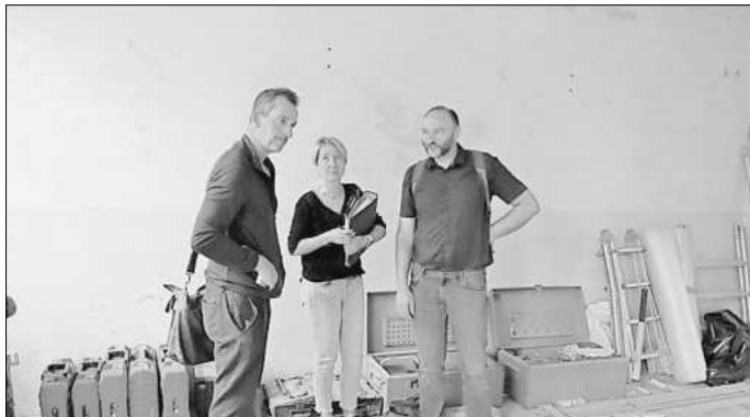
Während der Bauberatungen: In der Mitte Architektin Frau Schildbach im Gespräch mit dem Chef einer Baufirma und Christoph Cron von der Bauabteilung der VG. Foto: Lämmerhirt
