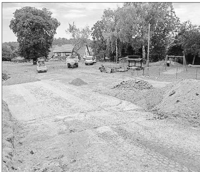
Baubeginn in der ersten Septemberwoche.
