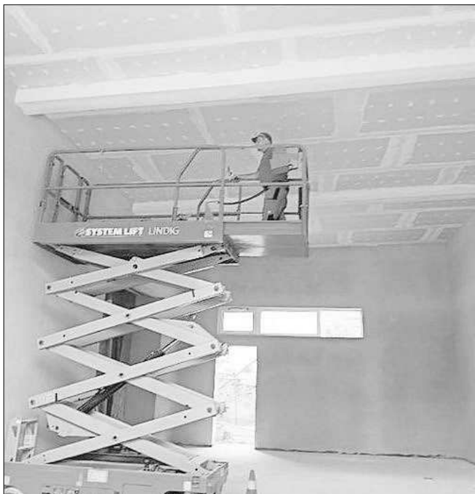
Am Anbau des Feuerwehrgerätehauses in Creuzburg wird der Innenausbau des Daches vorangetrieben.
