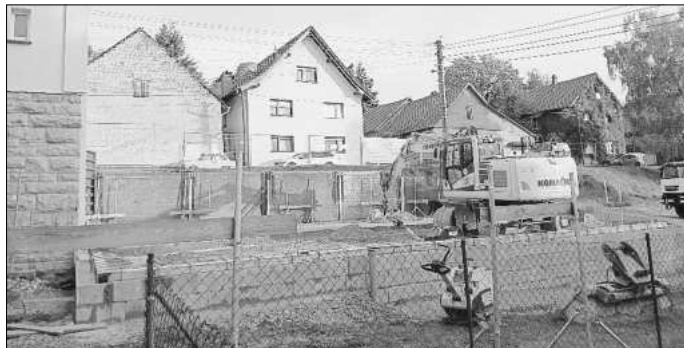
Stück für Stück wachsen die Mauern des Rohbaus an der alten Scherbdaer Schule empor. Fotos: R. Lämmerhirt
