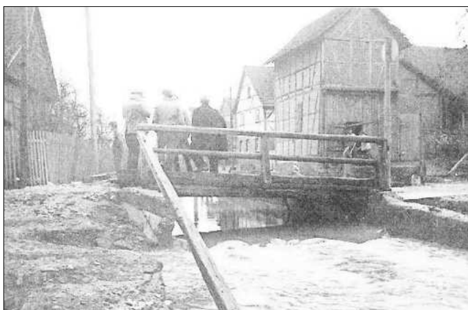
Hochwasser der Lauter in den 30er Jahren. Gut zu sehen die Steineinfassung des Bachbettes, aufgenommen am „Steg“ beim Ölberg.
