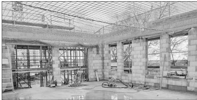
Gut vorangekommen ist der Neubau an der alten Schule in Scherbda. Foto: R. Lämmerhirt
