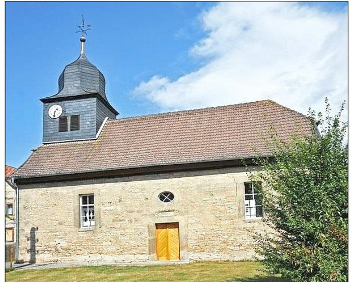
Der Kirchenbau ist einfach ausgeführt. Das Kirchenschiff misst eine Länge von gut 15 Metern und ist acht Meter breit. Eine tonnenförmig gestaltete Holzdecke schließt es ab, die Fenster sind ebenso wie der Eingang schlicht rechteckig gestaltet ohne Schmuckelemente. Auf der Westseite erhebt sich ein beschiefelter rechteckiger Dachstuhl mit geschweifelter Kuppel und Wetterfahne.
