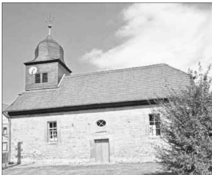
Die Turmuhr in der Ebenshäuser Kirche ist mechanisch und muss mehrfach in der Woche aufgezogen werden. Der Auftrag für den Einbau einer elektrischen Anlage ist bereits vergeben.
