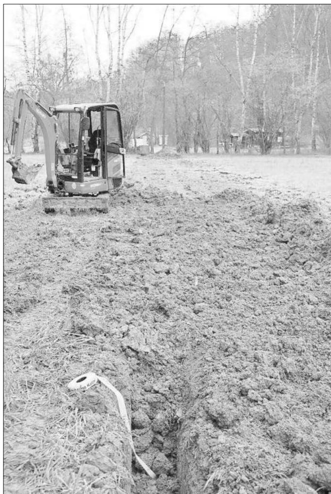
Verlegung des Erdkabels für den Stromanschluss am Campingplatz Ebenshausen
