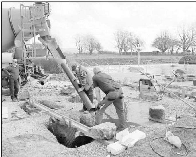
*Endlich spielt das Wetter mit, der Beton kann in die Fundamentgruben fließen.*
