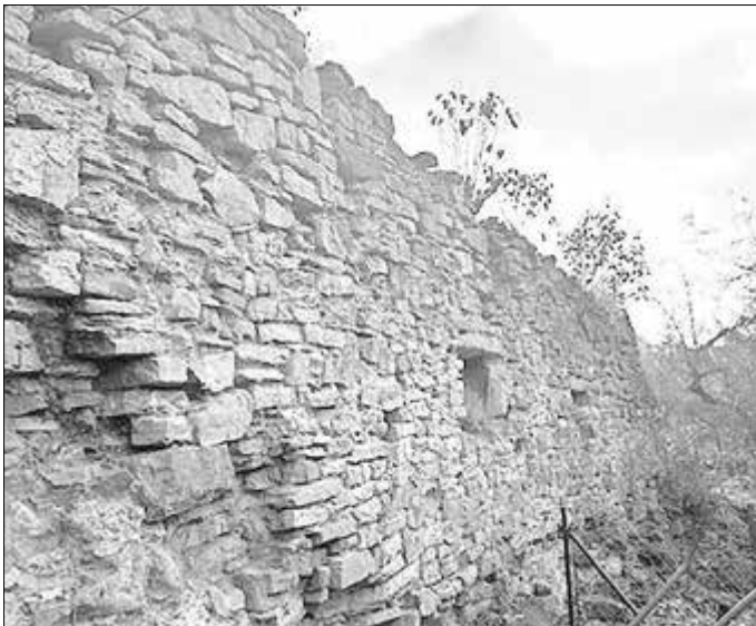
Der Creuzburger Stadtmauerturm muss rasch saniert werden. Bei den statischen Untersuchungen stellte sich heraus, dass eine Sanierung nur möglich ist, wenn auch der anschließende Mauerzug der Stadtmauer erneuert wird Fotos: Schachtschabel
