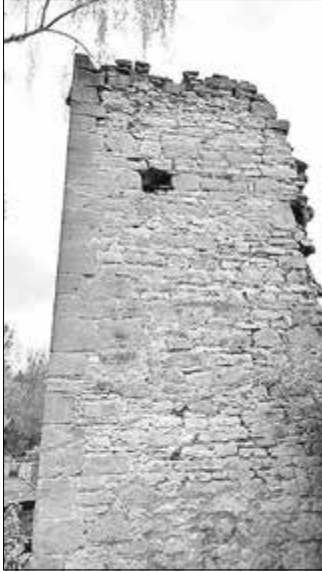
Der Creuzburger Stadtmauerturm muss rasch saniert werden. Bei den statischen Untersuchungen stellte sich heraus, dass eine Sanierung nur möglich ist, wenn auch der anschließende Mauerzug der Stadtmauer erneuert wird Fotos: Schachtschabel
