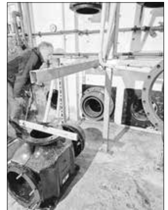
Der Einbau der neuen Pumpen beginnt. Foto: Isabel Endregat
