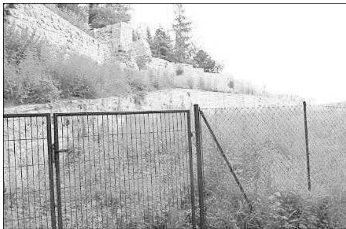
Stadtmauer, östlicher Abschnitt von Westen
