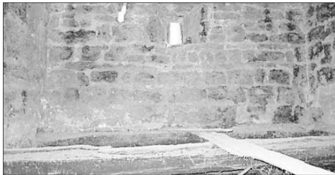
Stadtmauer, Schalenturm im westlichen Abschnitt, Nordwand des Turms von Süden
