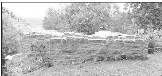
Stadtmauer, östlicher Abschnitt mit Schalenturm von Nordosten Der rechteckige Schalenturm ist feldseitig nur in geringer Höhe erhalten. Die Instandsetzung erfolgte im Jahr 2013.
