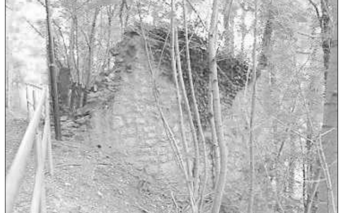
Stadtmauer, nordwestlicher Abschnitt von Westen
