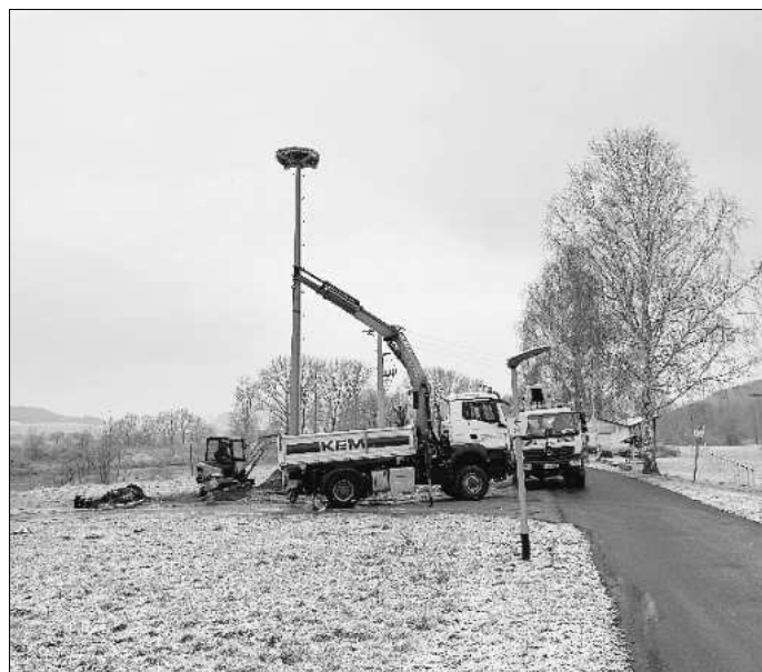
... und Ausrichten des Mastes
