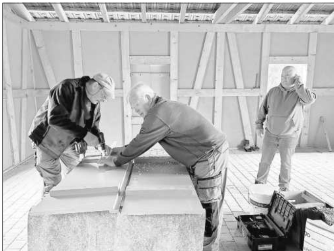
Unter fachmännischer Anleitung werden die Fensterläden montiert.
