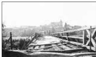
*Der schlechte Bauzustand der beiden Holzbrücken über Mühlgraben und Werra führt immer wieder zu Notreparaturen. Die Tragfähigkeit der Brücken ist in Frage gestellt, für einen modernen Neubau fehlt das Geld. Die Fotos, hier die große Brücke über die Werra, entstanden Ende der 20er Jahre und zeigen recht anschaulich die Probleme.*
