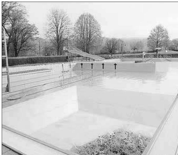
*Das Altwasser ist abgelassen und das Edelstahlbecken wird poliert. Im tiefsten Bereich unter dem Sprungturm steht noch ein letzter Rest des Überwinterungswassers. Foto: Ortschronist*
