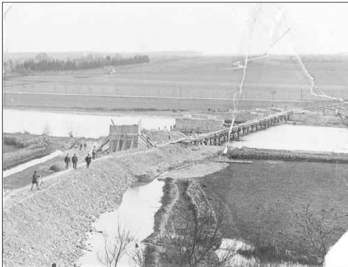
Die erste Aufnahme, das Foto wurde uns von Herrn Henry Fehr zur Verfügung gestellt, entstand während des Baus der Werrataleisenbahn im Frühjahr 1907. Der Fotograf hat die Bauarbeiten an der Mihlaer Eisenbahnbrücke über die Werra aufgenommen. Er steht auf dem zweiten Brückenbauwerk, welches damals entstand, dem sogenannten „Viadukt“.
