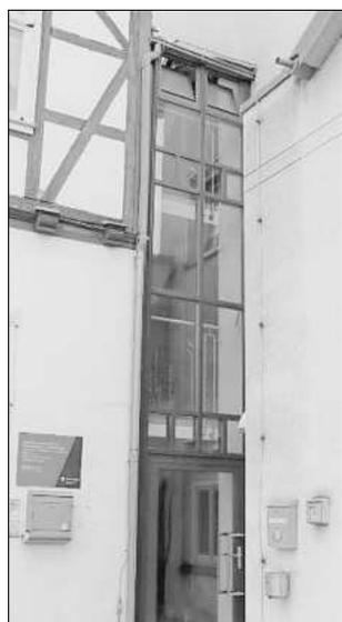
Der Glasaufbau der Treppenanlage in die oberen Diensträume der Feuerwehr Creuzburg ist seit längerer Zeit undicht. Nun konnte durch die Bauabteilung der VG eine Fachfirma gefunden werden, die den Neubau ausführen wird, wenn der Stadtrat den entsprechenden Beschluss fassen wird. Eine Reparatur ist nicht mehr möglich, da es für die Schienen und Träger nach beinahe 30 Jahre der Nutzung keine Ersatzteile mehr gibt. Die Baumaßnahme steht mit über 40.000 € zu Buche.
