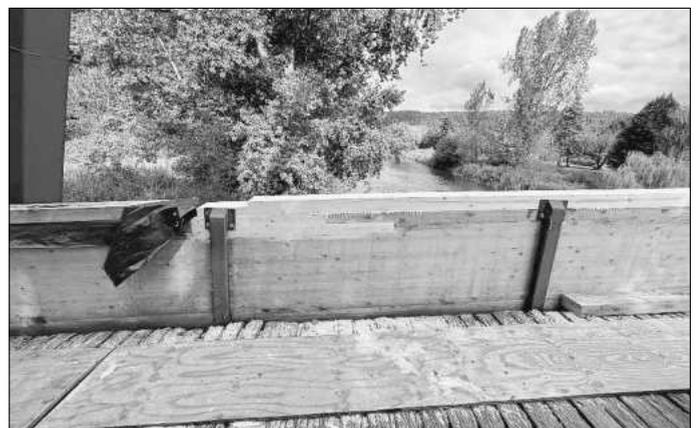
Auf dem zweiten Foto ist gut zu erkennen, wie die schadhaften Bereiche im alten Holz ersetzt werden, eine sehr aufwändige Arbeit
