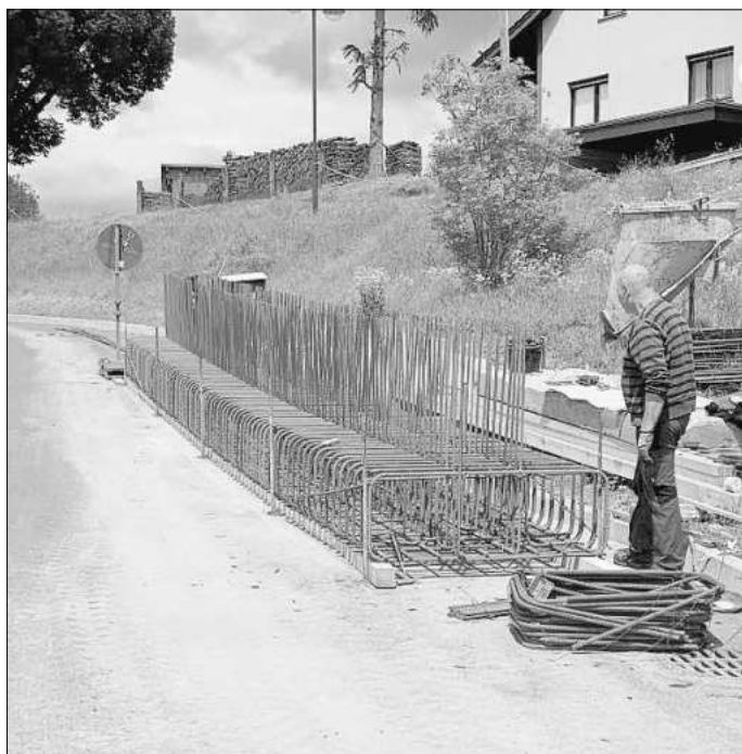
Die Bewehrung für das Brückenfundament wird vorbereitet.
