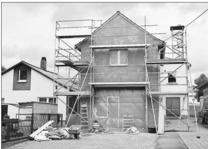
*Am Feuerwehrgerätehaus wird nach dem Abschluss des Innenausbaus die Fassade geputzt.* Fotos: R. Lämmerhirt
