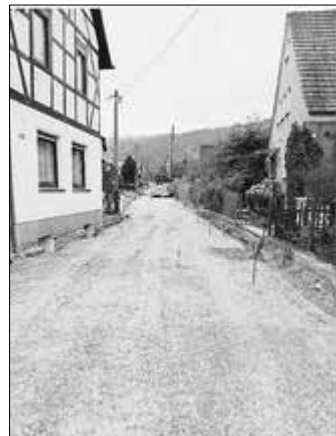
In der Oberen Lohfeldstraße sind die Bauarbeiten weit vorgeschritten. Der Straßenkörper wird für das Einbringen der Bitumendecke vorbereitet.
