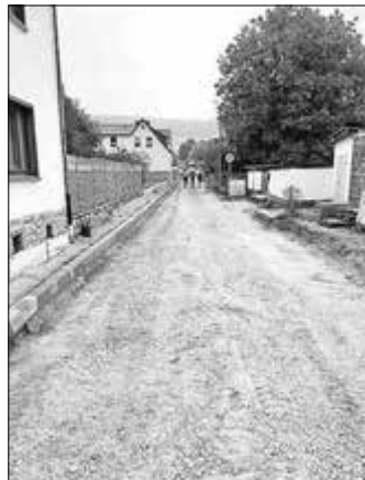
In der Oberen Lohfeldstraße sind die Bauarbeiten weit vorgeschritten. Der Straßenkörper wird für das Einbringen der Bitumendecke vorbereitet.
