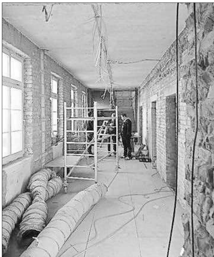
In einem der Hauptflure wird intensiv gearbeitet. Foto: R. Lämmerhirt
