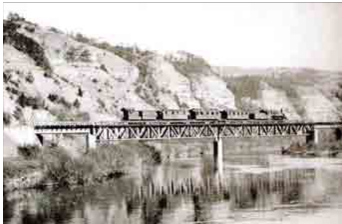
Ein Personenzug überfährt die große Werrabrücke bei Ebenau.
