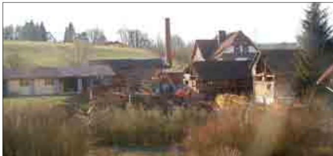
Der Abriss läuft.
