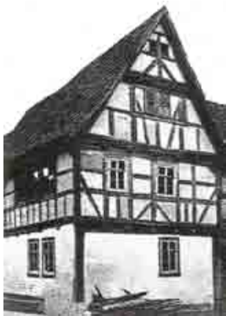
Wohnhaus Meng in Mihla auf einer Aufnahme um 1900. Die unregelmäßig gebogenen Wandstreben im Giebelbereich lassen auf eine Umbauzeit um 1670 schließen.
