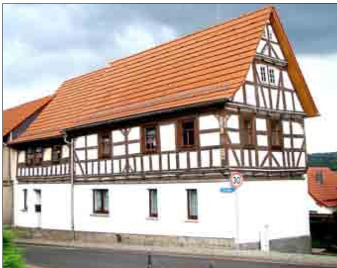
Das liebevoll sanierte Fachwerkhaus im Sommer 2016.
